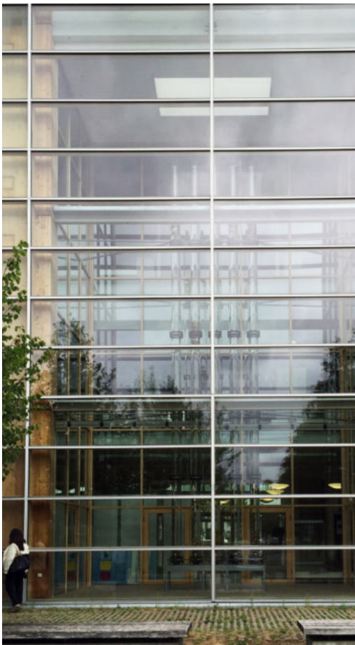
Abb. 106 | thermische Pufferzone zur Sammlung und Speicherung solarer Wärme
