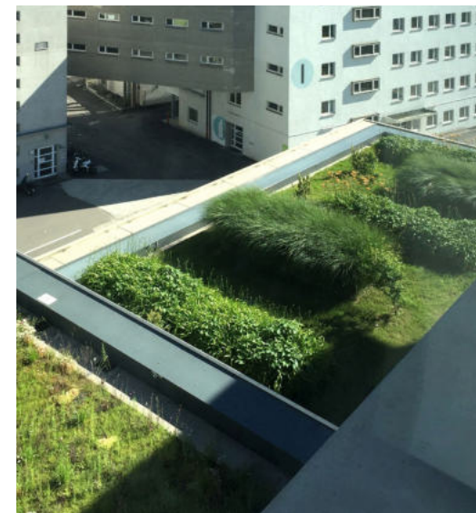
Abb. 130 | Beispiel eines intensiv begrünten Flachdachs
