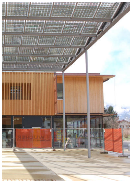
Abb. 119 | gestalterische Integration von Solarsystemen in einer Glasüberdachung am Beispiel des Gemeindezentrums Ludesch
