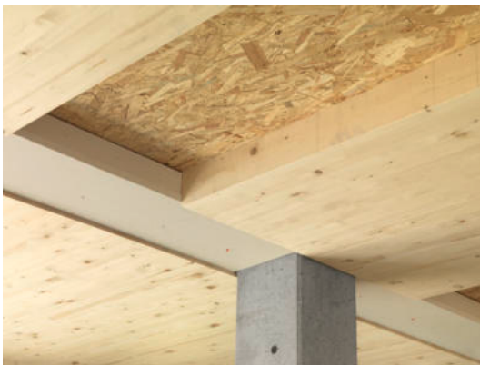
Abb. 114 | Hybrid-Konstruktion bestehend aus Stahlbetontragwerk und Holzmassivbauelementen
