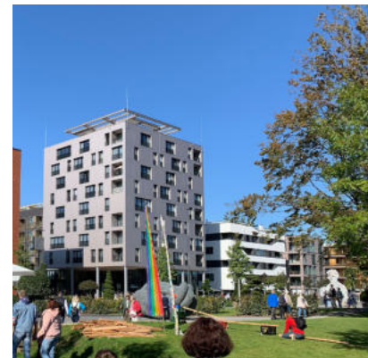
Abb. 116 | Hochhaus in Holzbauweise am Beispiel SKAIO, Heilbronn
