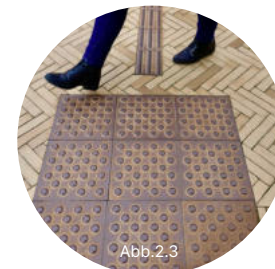
Leitsystem Metallnoppen / -rippen
