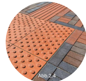
Leitsystem aus Pflastermaterial Noppen / Rippen
